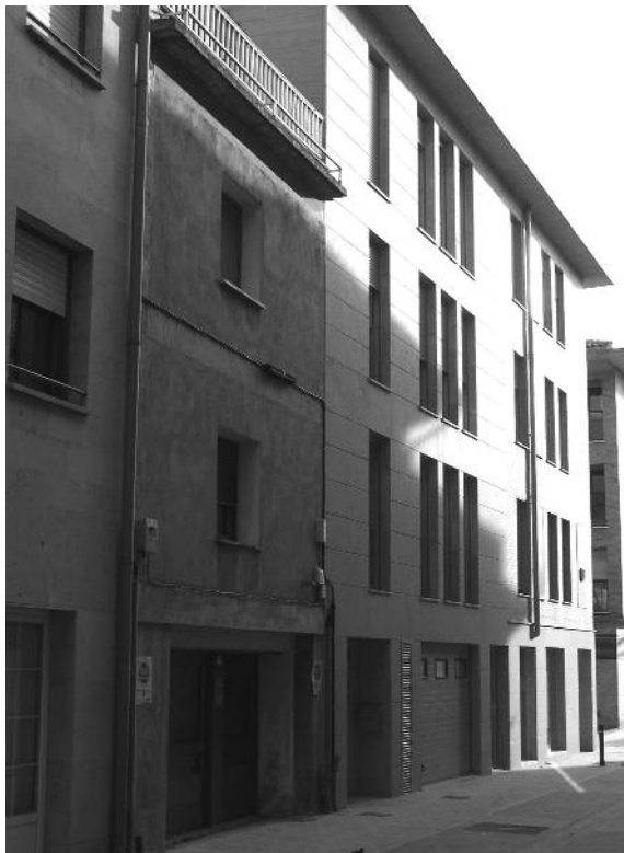
15. Estado actual del edificio, situado en el nº 44 de la calle Mayor de Villava, que albergaba a la Casa del Pueblo durante la República (el autor).
