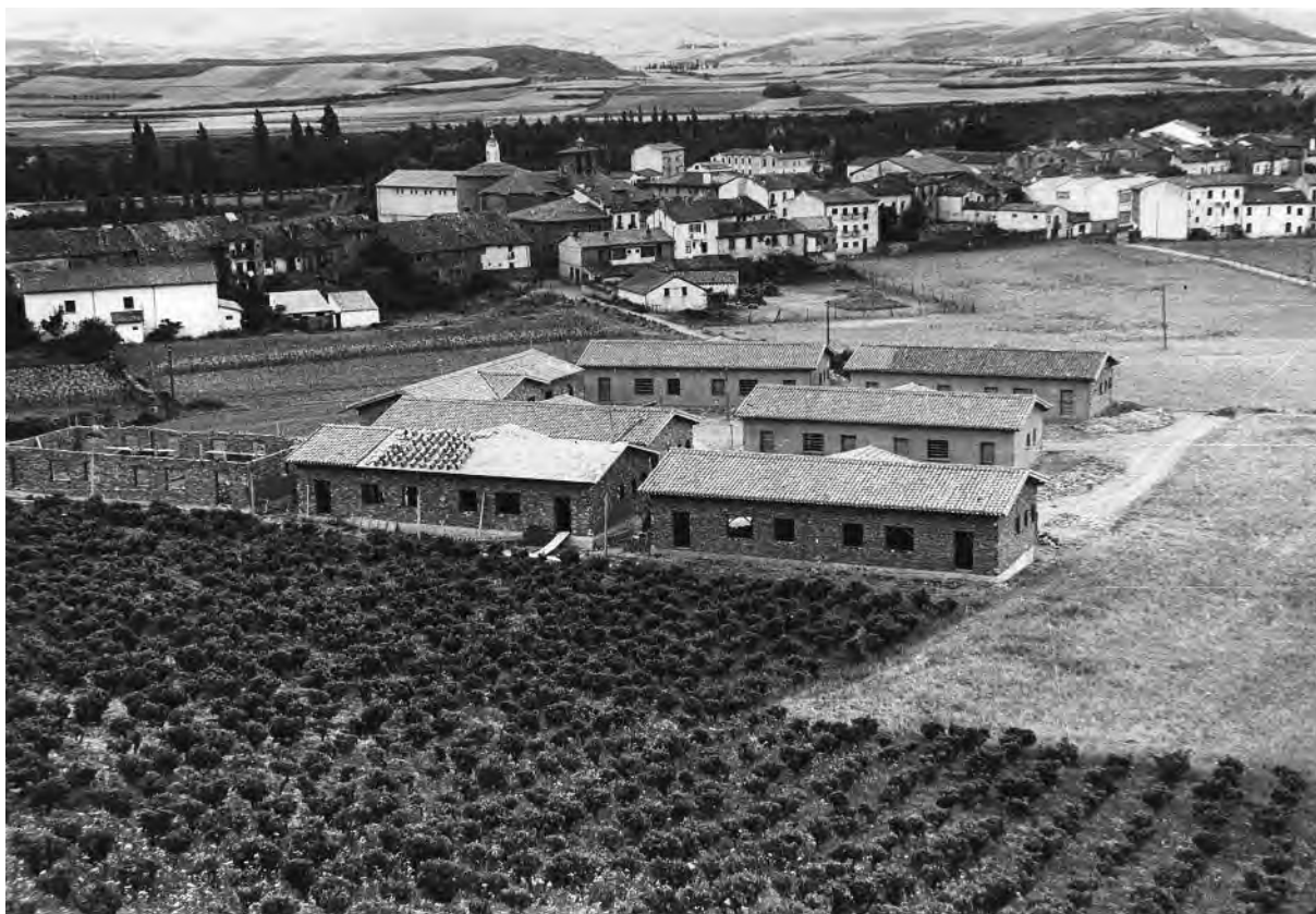
7. La colonia de San Francisco durante su construcción, en 1951. Al fondo, el núcleo urbano de Villava cuando éste se reducía, prácticamente, a su Calle Mayor (Autor: Z. Ecay. Fotografía cedida por T. Donázar).
