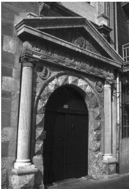
Portada renacentista de la Casa Motza, construida hacia 1550.
