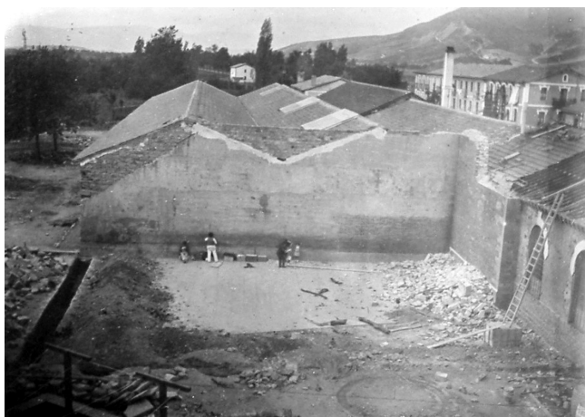
...días después, convertido en ruinas.
